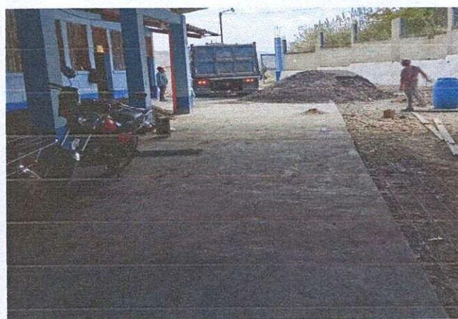
Foto 2: Losa de patio
