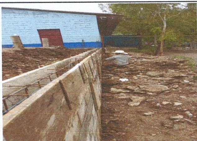
Foto 3: Reparacion de muro de contencion
