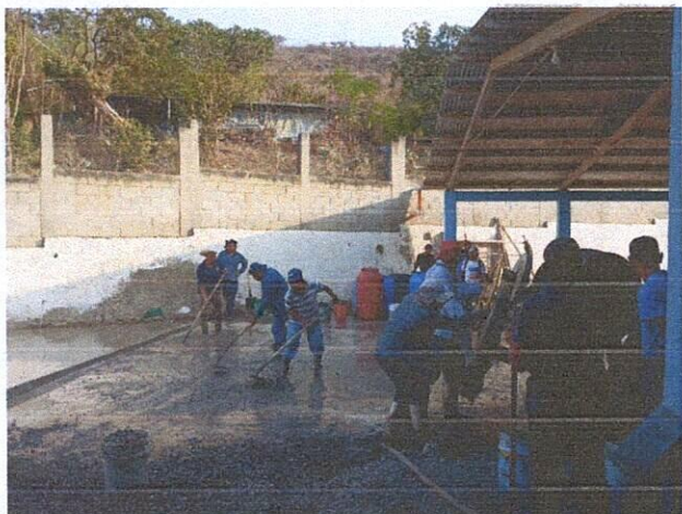
Foto1: Losa de patio
