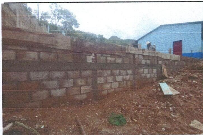
Foto 4: Reparacion de muro de contención
