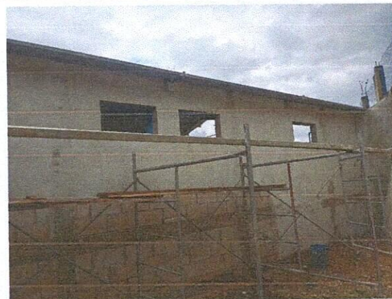
Foto 4: Reparación de repello y cernido de paredes
